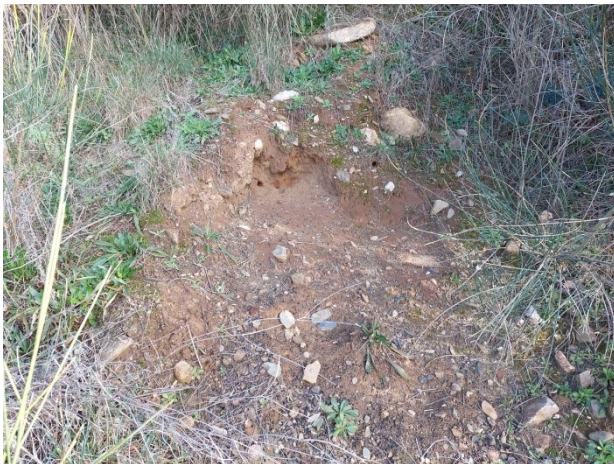
Photo 38 : Désordre n°4 – Fossé et flanc non recouverts (05/01/22)
