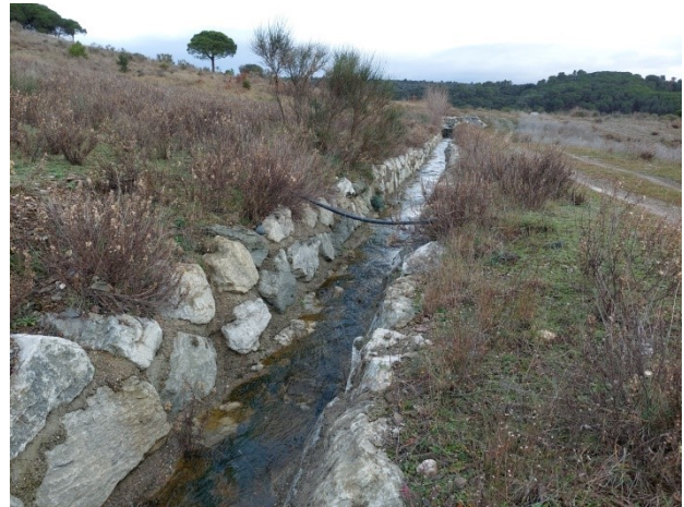
Photo 47 : Caniveau d'évacuation des eaux pluviales traversant le champ Magné (29/12/21)
