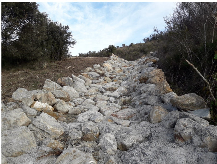
Photo 7 : Descente d'eau vers le drain de pied du flanc Est de Montredon
