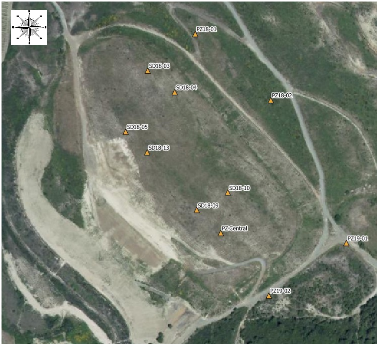
Figure 74 : implantation des piézomètres de surveillance de Montredon durant les travaux
