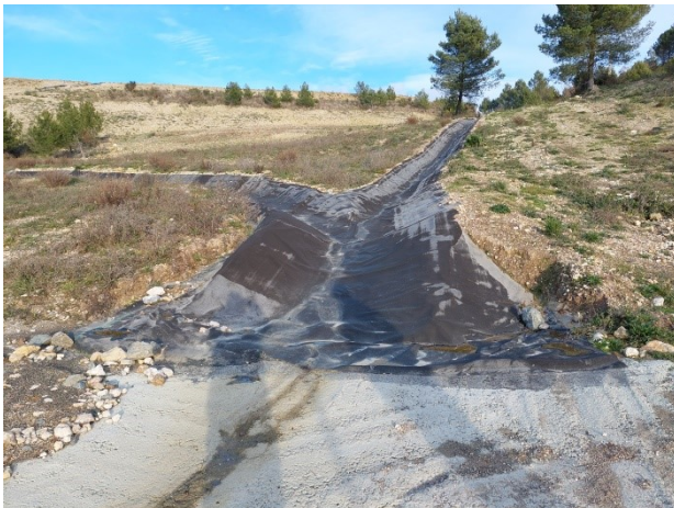
Photo 10 : Descente d'eau avec membrane bitumineuse flanc Ouest (20/12/21)
