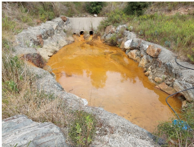
Photo 35 : Bassin de collecte des drains inférieurs (09/09/21)
