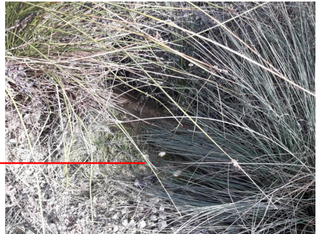
Photo 6 : Sortie du drain de pied du flanc est de Montredon (26/01/21)
