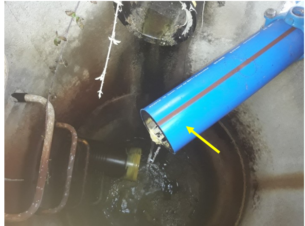
Photo 4 : Nouvelle conduite unique du drain Montredon et des 4 puits de pompage au niveau du regard de la station (24/08/21)
