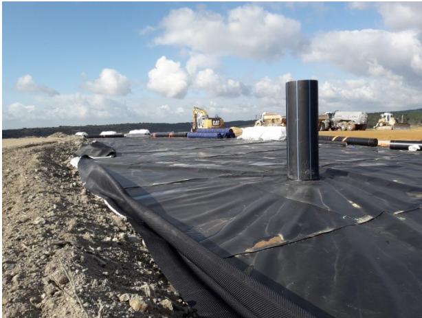
Photo 1 : Puits et raccordement au complexe d'étanchéité (16/03/21)
