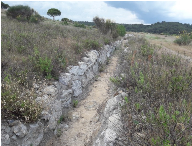
Photo 46 : Caniveau d'évacuation des eaux pluviales traversant le champ Magné (21/06/21)
