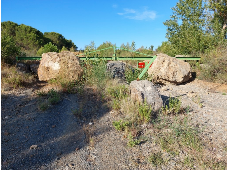
Photo 57 : Accès condamné à l'ancienne plage (30/08/21)
