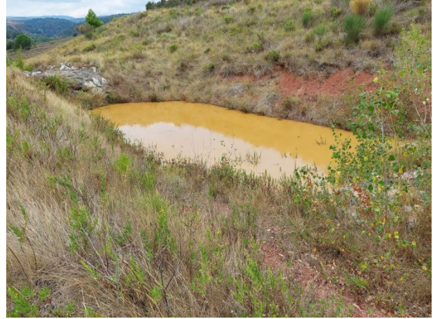
Photo 37 : Bassin de dissipation d'énergie vue depuis le déversoir amont (09/09/21)
