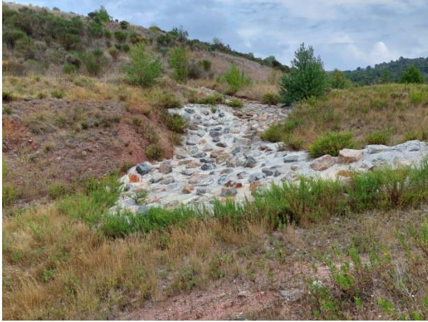
Photo 36 : Déversoir amont vers le bassin de dissipation d'énergie (09/09/21)
