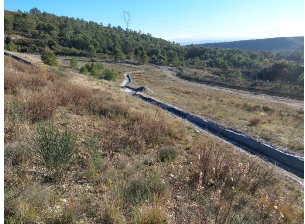
Photo 9 : Flanc Ouest de Montredon (17/12/21)
