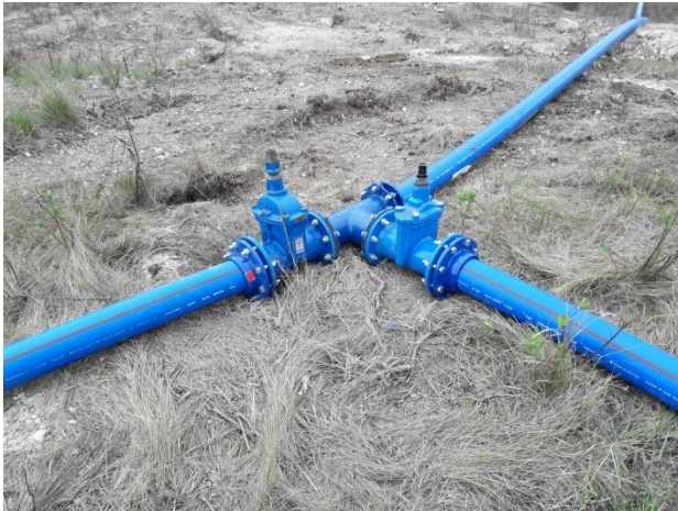
Photo 3 : Jonction des deux nouvelles conduites des drains D1 et D2 (10/05/21)
