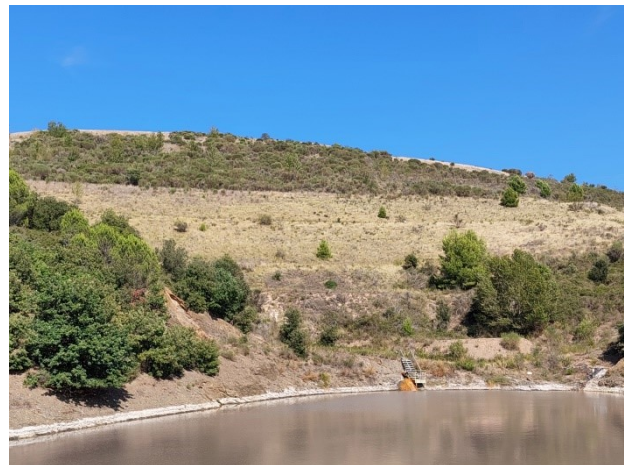
Photo 31 : Point de vue n°3 – flanc nord-ouest et piste refaite (30/08/21)
