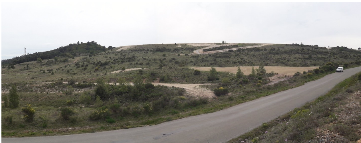
Photo 23 : Panorama du flanc est du stockage de Montredon (21/05/21)
